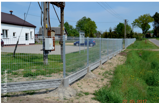
Nowe ogrodzenie przy Świetlicy Wiejskiej w Porozu
