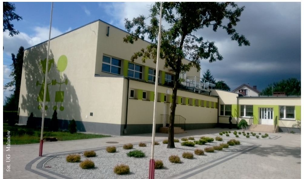
Budynek Szkoły Podstawowej w Malanowie
