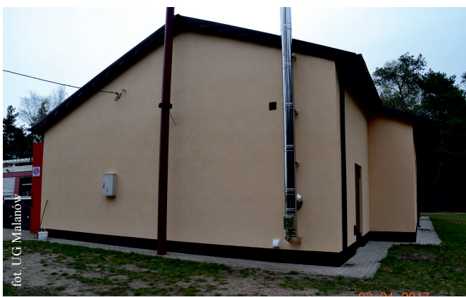
Wyremontowana elewacja w Świetlicy Wiejskiej w Feliksowie
